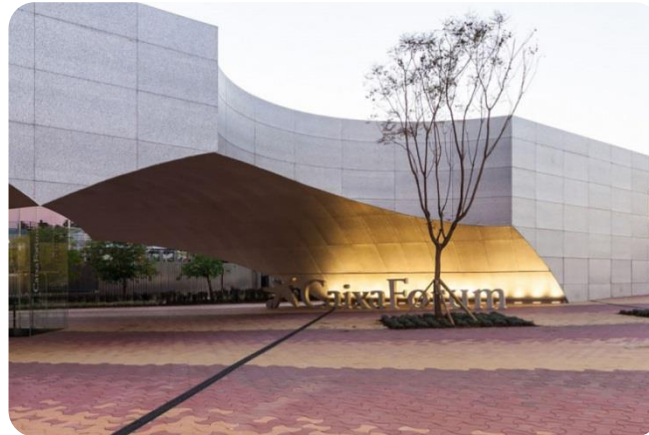
Caixa Fórum (Sevilla)
