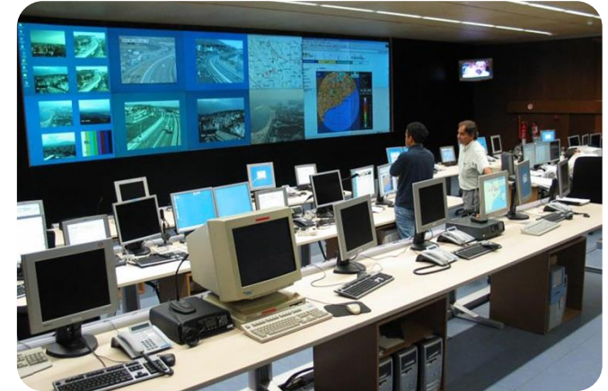
Centro de Control del CECAT (Barcelona)
